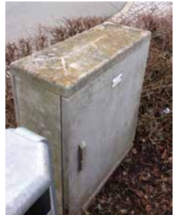
„Blooming“ und starke Verschmutzung nach einigen Jahren
